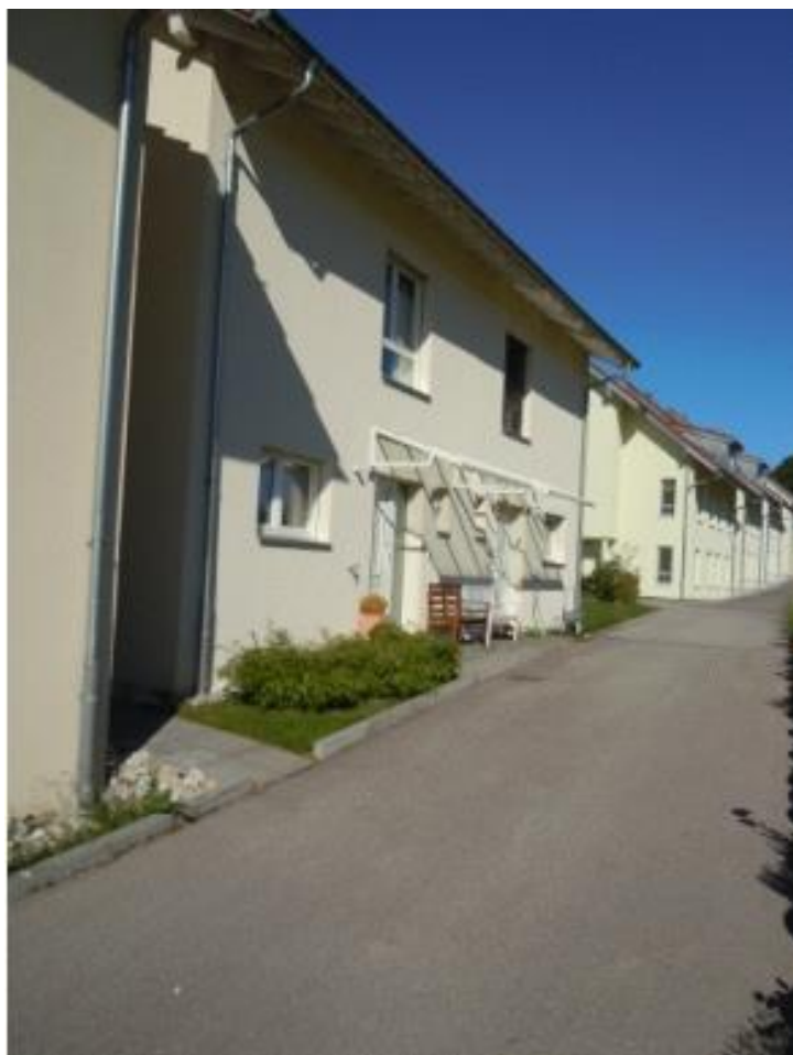
Entrée de la maison mitoyenne (au centre)
