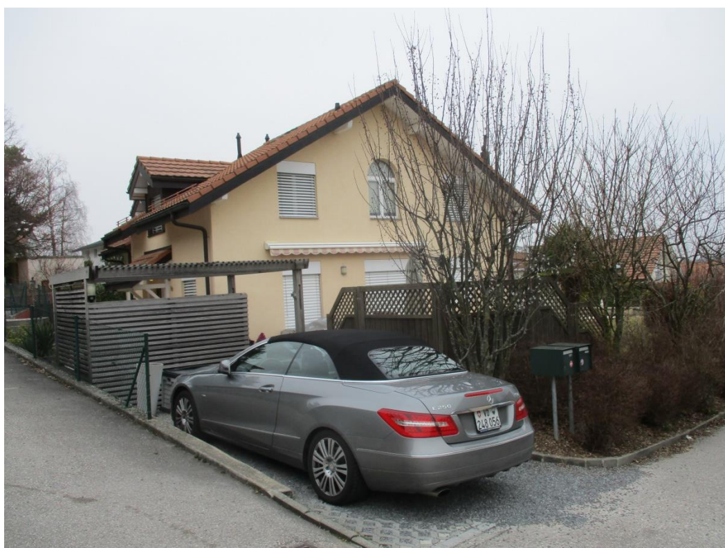
Vue de l'ouest
