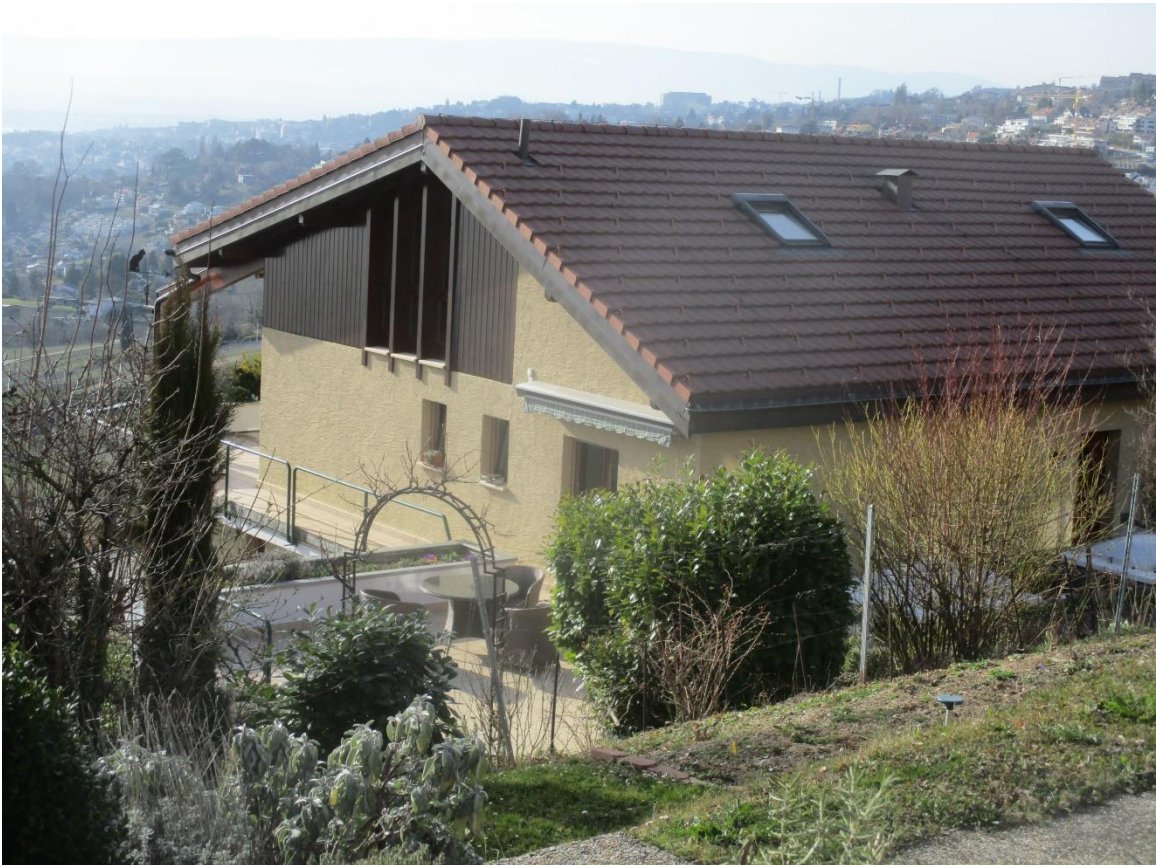
Vue de la façade nord-est
