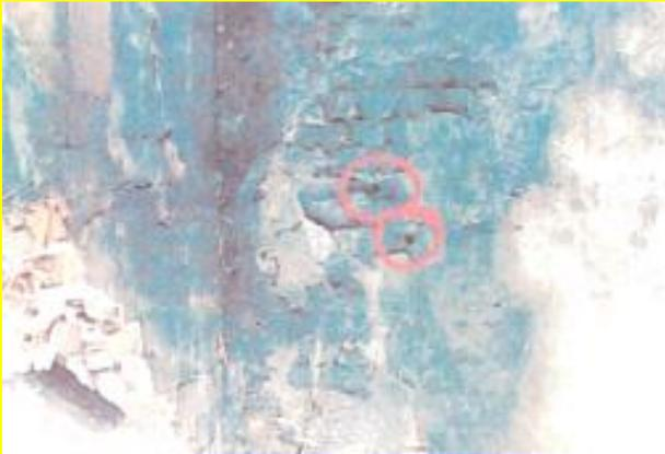
Die Bohrlöcher von BUDRY im Lüftungsschacht von GUTKNECHTs Stall. BUDRY hatte die Brandmauer zwischen den beiden Häusern durch-bohrt.
